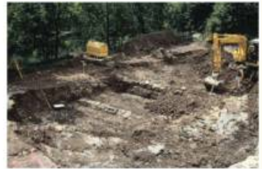
Blick in die Baugrube.
