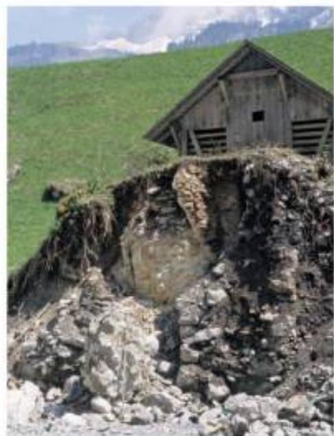
Ruine des Hochofens mit aufgerissenen Schacht nach der Rodung; Blick von Südwesten am 11.05.2006. Die doppelkonische Form des Schachtes tritt an der Abrisskante deutlich hervor.
