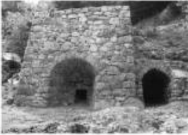
Der 2006 im Melchtal entdeckte Hochofen scheint gleich konstruiert zu sein wie der von 1979-1984 bei Salouf (GR) sanierte Floss- bzw. Hochofen aus dem Jahr 1828.
