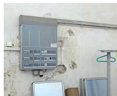
Heutiges Elektrotableau mit Zu- und Wegleitungen an der Nordwand des Bibliothek-Nebenraumes.
