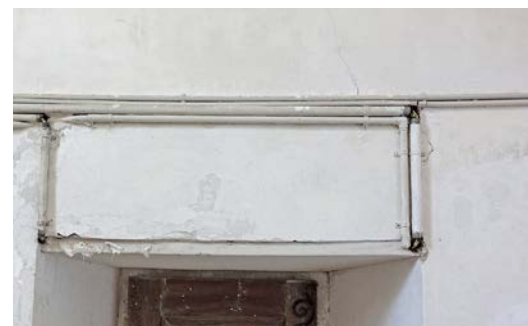
Detail heutige Elektroinstallationen auf den Wandflächen.
