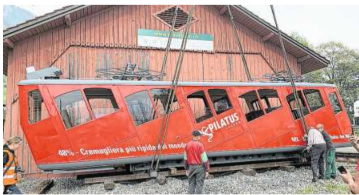
Mit dem Kran wird der ausrangierte Triebwagen an seinen provisorischen Standort gebracht. Bild: Robert Hess (Alpnachstad, 20. 10. 2022)
